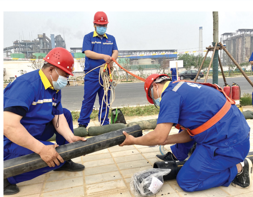
为切实做好燃气行业防汛紧急避险工作,提升汛期燃气管网事故应急处置能力,4月26日,区天伦燃气有限公司开展了汛期管网泄漏应急演练。本次演练成立应急救援指挥部,下设抢险抢修组、应急控制组、警戒疏散组、防汛救援组、技术组、物资调配组6个小组,25人参加,配备物资工具20余种,以突出实战化为原则,准备充分,配合密切,紧张有序,为事故应急救援抢险处置积累了工作经验。
