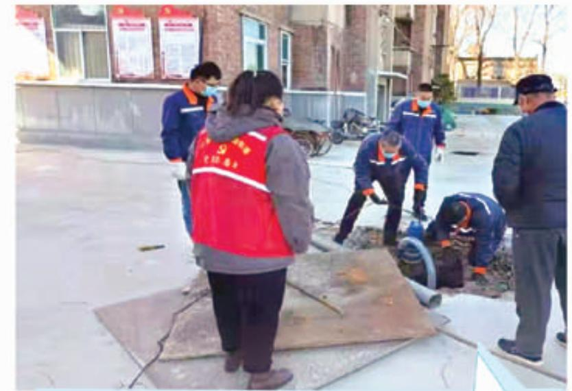
新安西路38号院属于老旧小区,基础设施建设较为薄弱,为快速有效解决居民诉求,社区充分发挥驻地企业资源丰富这一优势,积极联系黄金矿建公司帮助解决。黄金矿建公司迅速响应,随即安排专业人员赶到楼院,对下水管道淤堵物进行了清掏,并使用高压水枪对管道内部进行全面冲洗。同时,社区工作人员主动提醒居民居民,不要随意往下水道内乱扔乱倒垃圾,避免造成堵塞。
