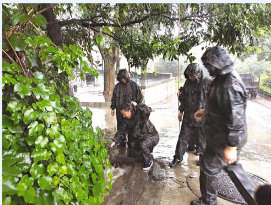
矿山办工作人员清理下水道淤泥,确保排水顺畅。
