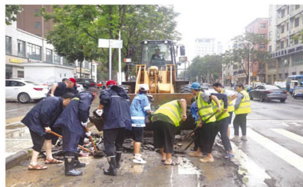
挖相结合的方式实施作业，加装阀门，预计10小时内恢复附近区域供水。
