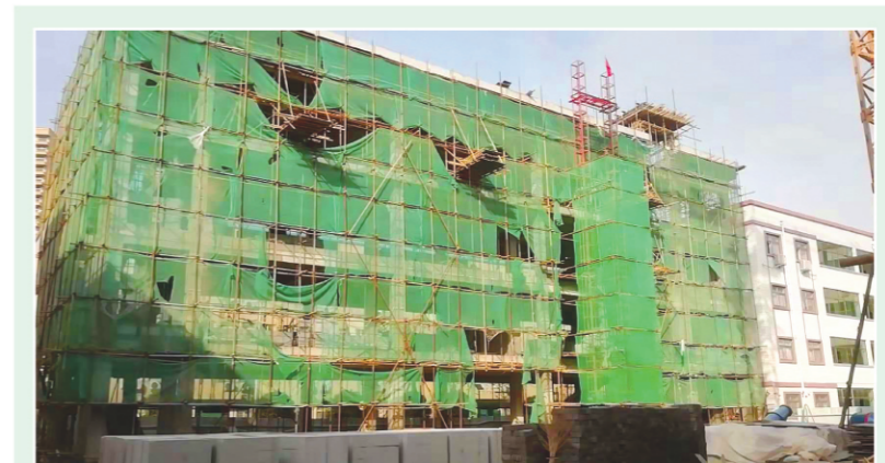
上街实验高中教学楼新建项目是我区今年重点项目之一,拟建教学楼两栋,总建筑面积约4500平方米,总投资1445万元。目前,该项目已完成四层主体封顶,正在进行砌体工程,预计12月底竣工。
