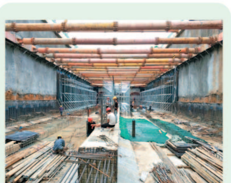
记者从区轨道办了解到,截至目前,地铁10号线上街段的5个站点除了市民中心站站台主体正在施工以外,其余的上街机场站、上街中站、峡窝站、金马路站均已实现站台主体结构封顶,已进入风亭、出入口、人行通道等附属设施的施工阶段。
