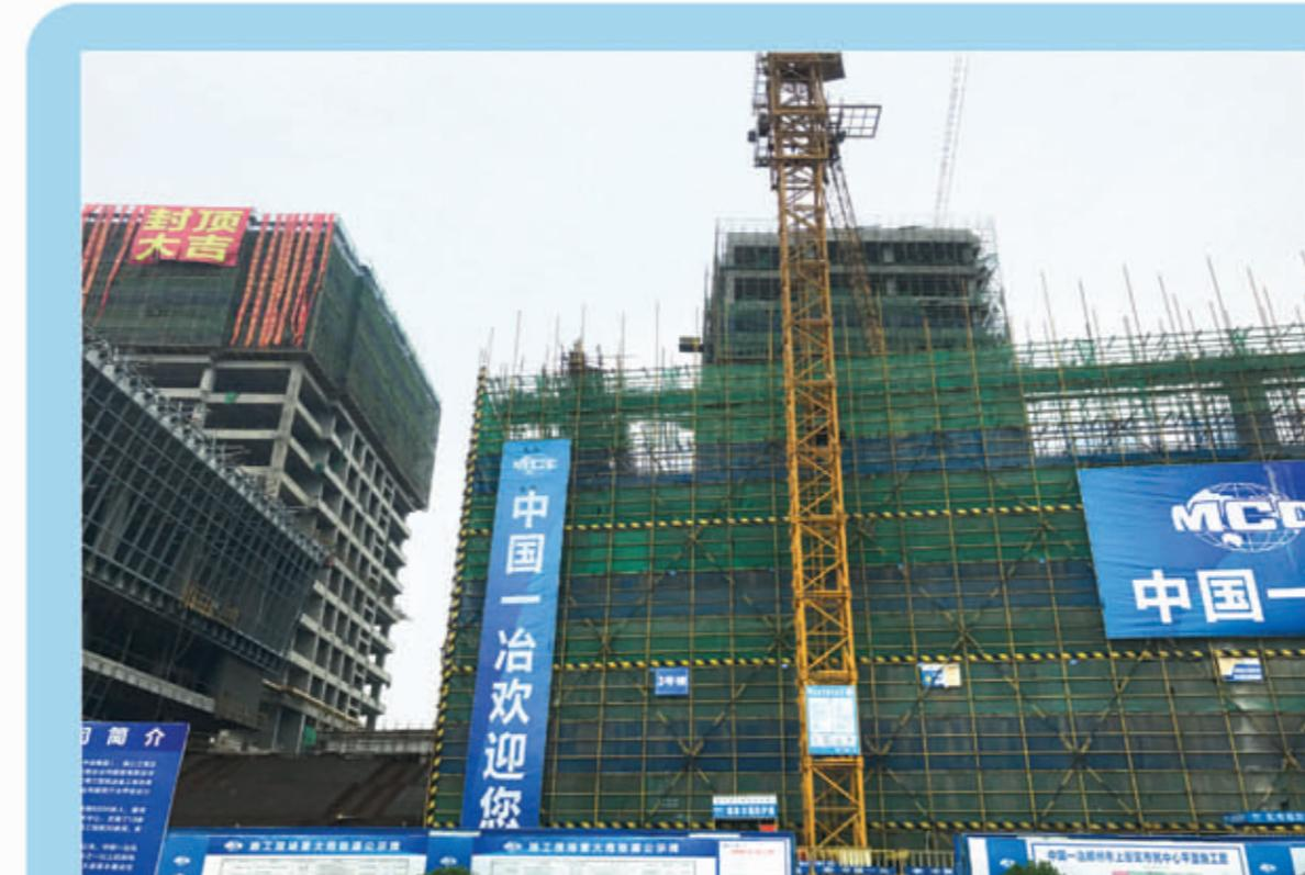
区市民服务中心项目位于登封路以东、锦江北路以北、实验初中以南。该项目是双子塔形式的建筑群，规划占地49亩，建筑面积约8.7万m<sup>2</sup>。建设内容包括健康体育中心、市民办事服务中心、活动中心、规划展览中心和容纳1000人的报告厅、新华书店等。目前1号主楼屋面层钢架模板施工完成30%，2号楼结构封顶，电梯机房结构浇筑40%，康体中心结构封顶，花架浇筑50%，报告厅结构封顶。
