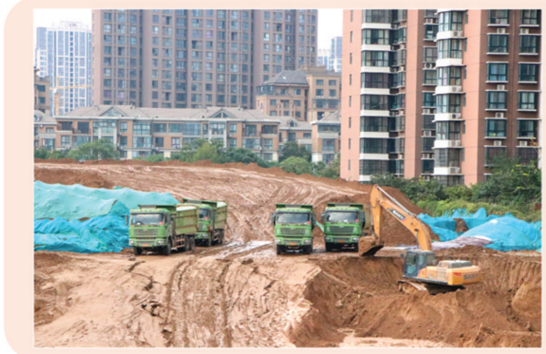
作为今年我区重点项目之一的许昌路小学建设项目,选址在许昌路以南,金屏路以东,占地53亩,总建筑面积约23万m 2 ,总投资约8000万元。拟建教学楼两栋,综合楼、报告厅、风雨球馆各一栋及配套的体育场地。目前,项目正在进行基础施工。
