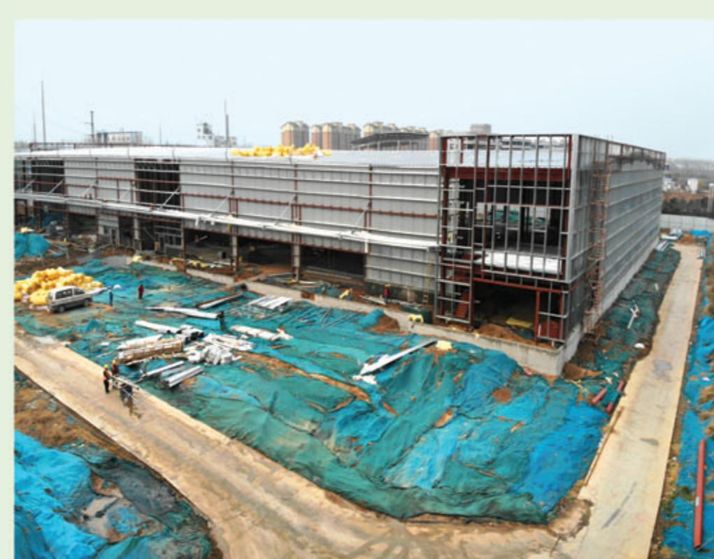
普洛斯郑州上街物流园项目总建筑面积7万平方米，集仓储、物流为一体，含电子商务、汽车零配件分拨结算、医药配送结算3个产业中心。目前，该项目土地证、用地规划许可证、工程规划许可证等手续已办理完成。一期消防水池回填完成；1号库防火隔墙施工完成，屋面板安装完成100%，内板安装40%；1号库、4号库外卸货平台挡土墙浇筑施工完成100%；2号库墙面次构架安装80%；3号库墙面次檩安装50%；4号库屋面板安装40%，办公区次檩安装40%。
