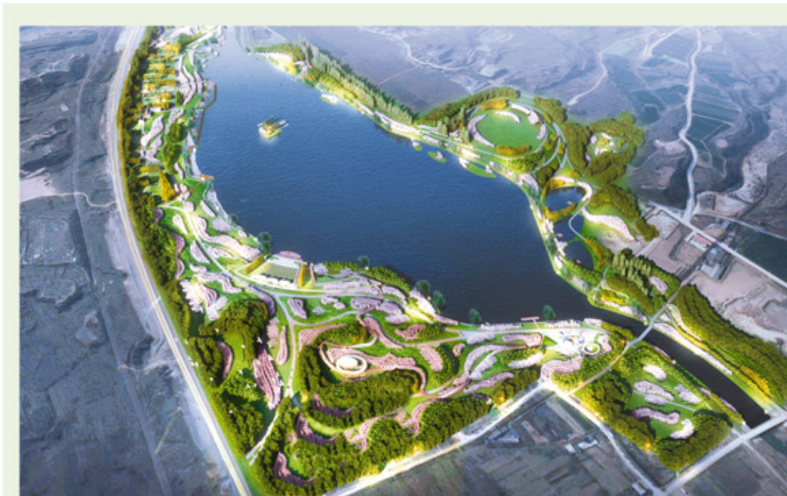
大溪湖公园项目9月25日开工,计划年底局部建成,实现部分开放,预计明年4月底前全部完工。目前,该项目土方作业和生态塔基础已完工,入口花坛完成80%,停车场完成40%,栽植苗木600余株,并进行养护管理,海棠馆地基正在施工。
