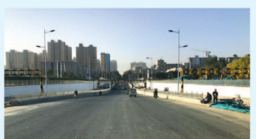
汝南路立交桥改扩建工程作为我区重点项目,于今年10月正式通车,有力地缓解了城区南北交通压力,方便了群众出行。(记者 雷霄 通讯员 张涛)
