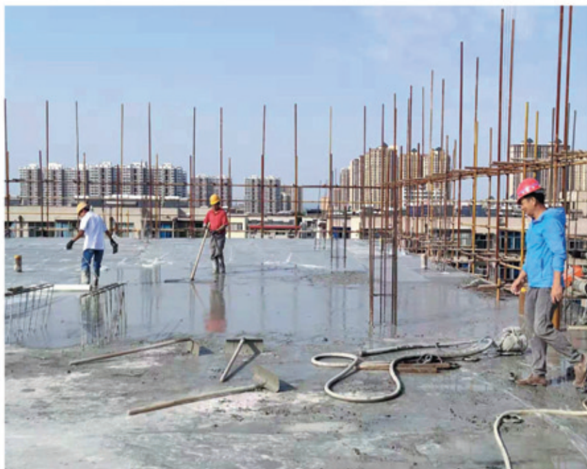
郑州市第十五人民医院续建项目是我区重点工程，目前门诊楼正在进行二三层主体结构施工，部分区域已封顶；病房楼正在进行三层主体结构施工。
